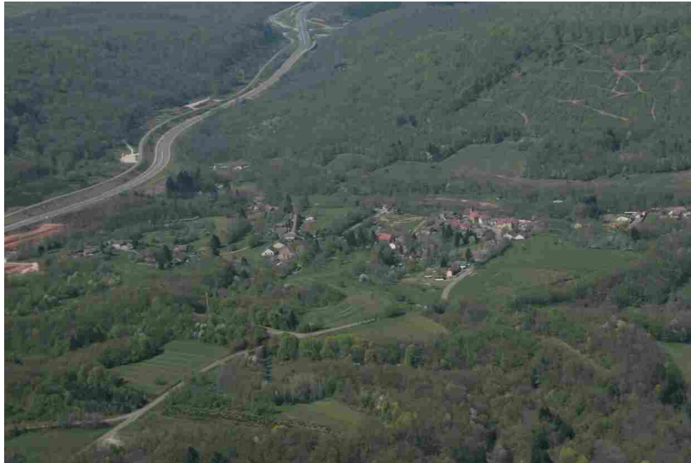
Photographie aérienne de Belverne (2007). Le bourg principal est entouré de prairies, formant une clairière au sein de la forêt. A gauche, le chantier de la Nationale 19 longe le territoire communal et crée une profonde entaille dans le massif forestier.
