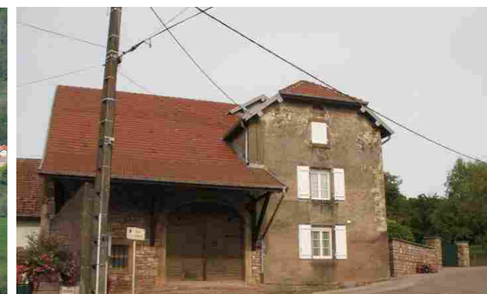
L'architecture traditionnelle est encore bien présente dans le paysage urbain de la commune. Le corps principal du bâti est construit sur 3 niveaux auquel est accolée la grange et sa belle porte cochère.
