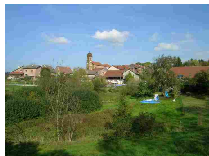
Vue sur la façade urbaine patrimoniale de Belverne depuis la rue du Fahiney. Cette impression de village perché ne pourra être maintenue qu'à la condition de préserver le caractère naturel et agricole du vallon situé en contrebas.
